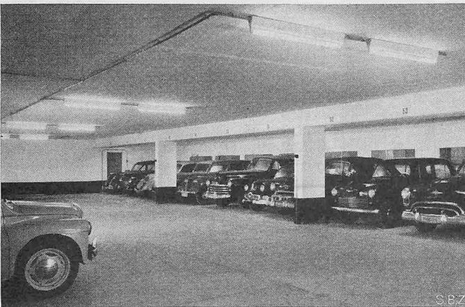
Bild 7. Garageraum mit bergseitigem Unterzug und Boxenreihe
