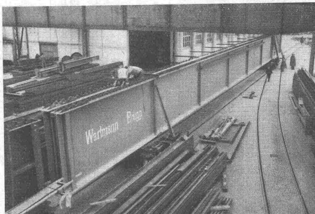
Versand von 2 Hauptträgern, 42 m lang, 2,8 m hoch, Einzelgewicht je 27 To
