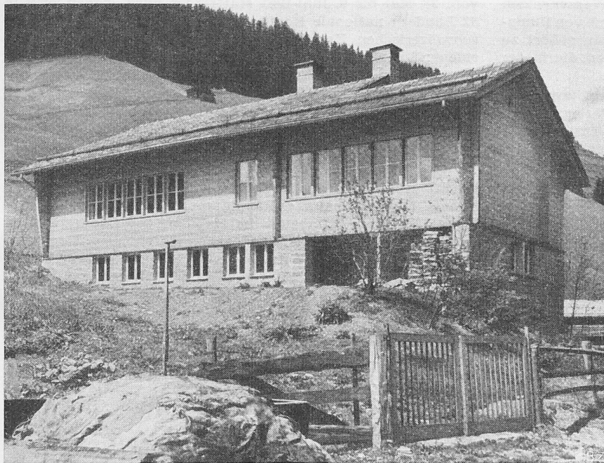
Bild 5. Das Schulhaus Safien-Platz von Süden
