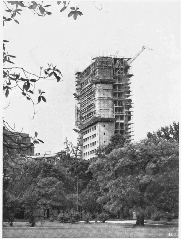
Bild 16. Ansicht des Turmbaues aus dem „giardino pubblico“
