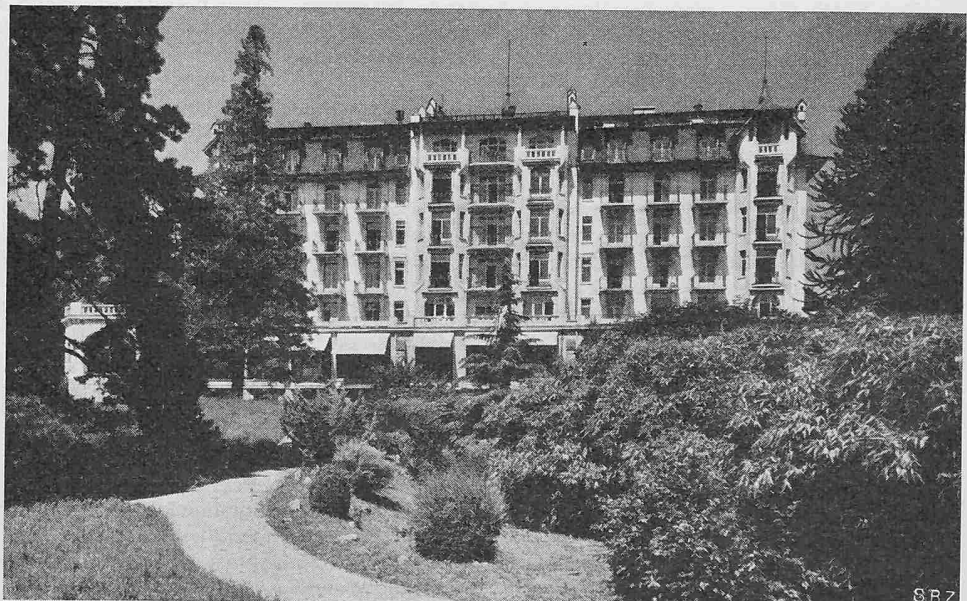
Das Hauptgebäude der EPUL an der Avenue de Cour in Lausanne
