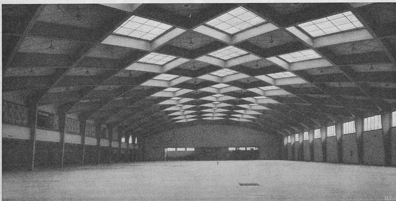
Die fertige Halle. Vollständig geschweisste Stahlkonstruktion; Zweigelenrahmen von 43,47 m Spannweite. Ing. M. COSANDEY, Lausanne
