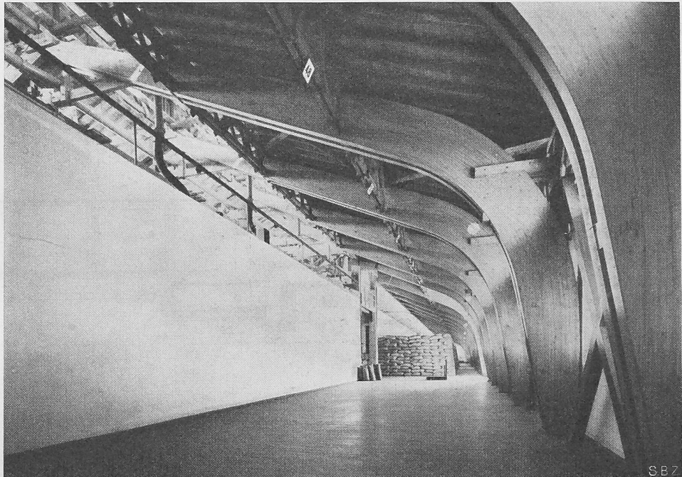
Bild 17. Magazinboden für Lagerung in Säcken zwischen Silo- und Aussenwand
