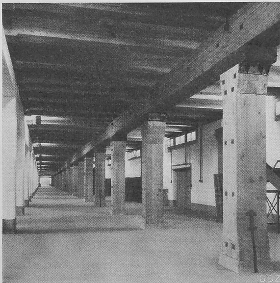
Bild 15. Untersicht des Magazinbodens
