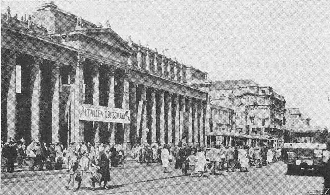
Bild 3. Der anschliessende Königsbau, eine feindetaillierte Kolonnade aus dem Ende des 19. Jahrhunderts, ist durch hässliche Reklamen fast noch mehr verunstaltet als durch die noch ungeheilten Wunden der Fliegerbomben.
