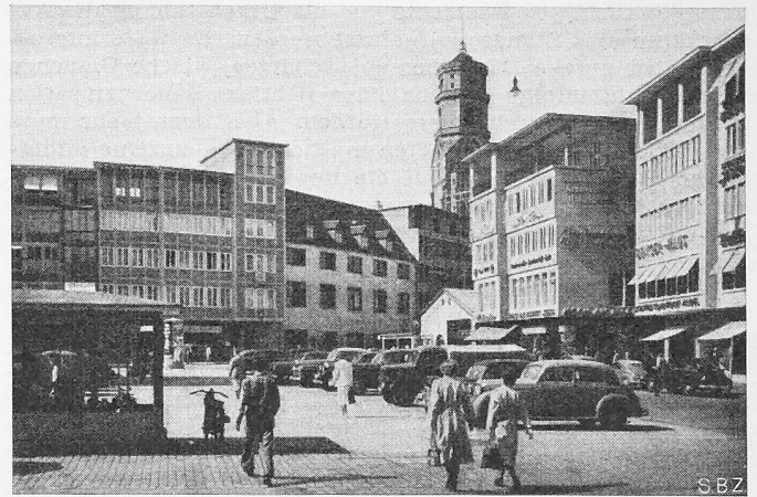
Bild 2. Marktplatz, Neubauzustand 1951. Die ordnende Hand der städtischen Planung hat beim Wiederaufbau, der sich in neuzeitlichen Formen und Materialien vollzieht, einen einheitlichen Masstab der kleinen Gliederung erreicht, wodurch der Geist des alten Platzes besser erhalten ist, als wenn man die früheren Formen in neuem Material hätte kopieren wollen.
