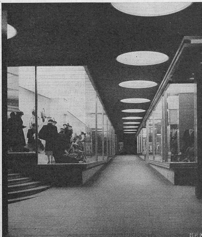
Bild 18. Schaufensterpassage Breuninger, Stuttgart
