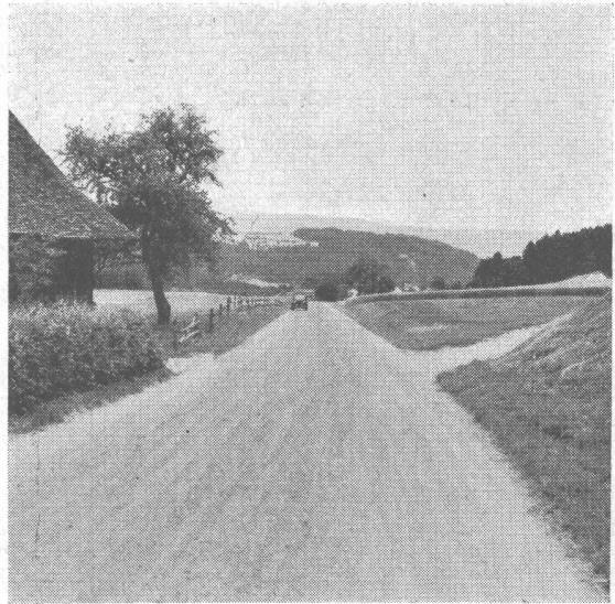
Strasse mit Bodenvermörtelung
