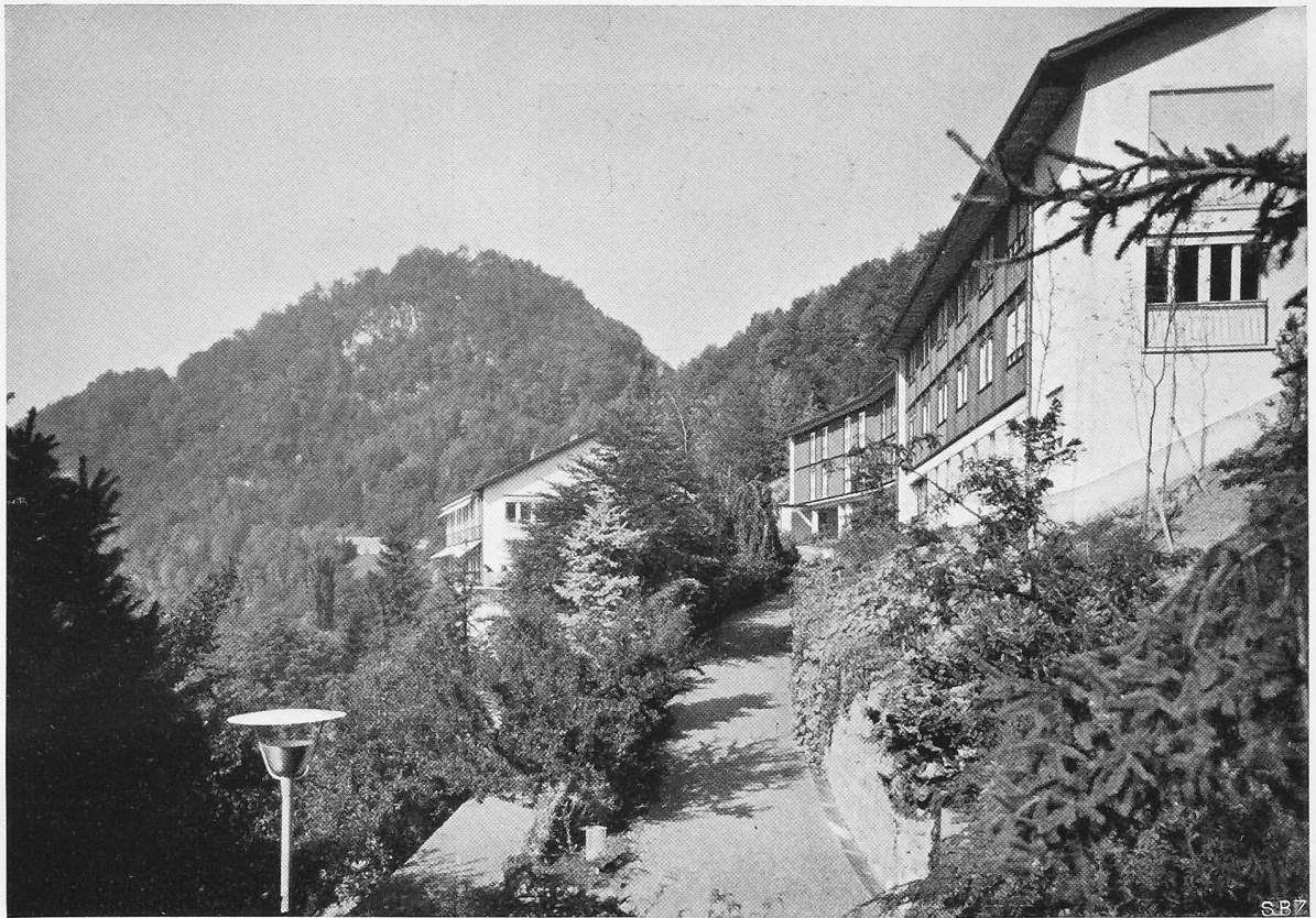
Bild 16. Gesamtansicht aus Südosten, rechts die Bettenhäuser
