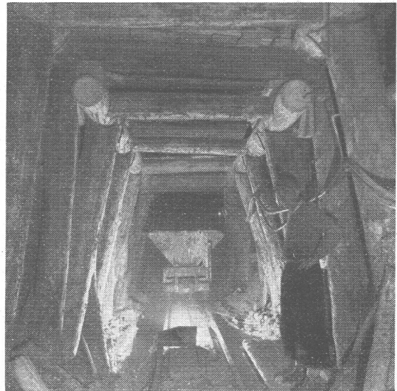
Stollen mit schwerem Einbau
