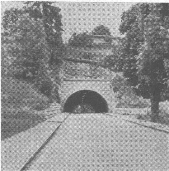
Strassentunnel Les Brenets
