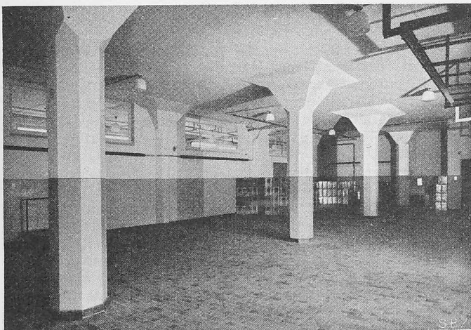
Bild 32. Oelabfüllerei, Raum im Erdgeschoss
