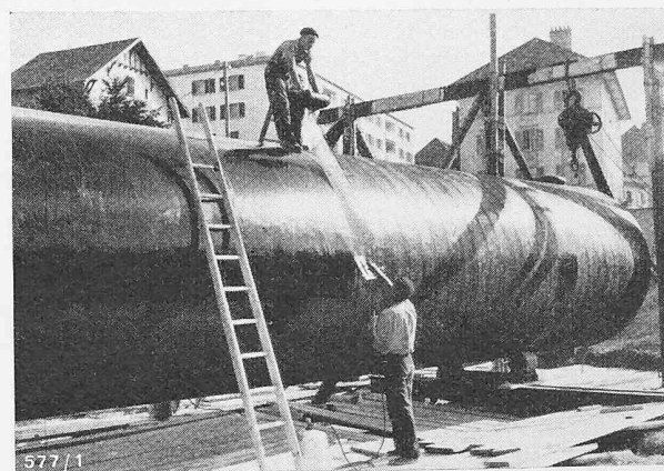
Bild 8. «Vetro-Waberit»-Isolation eines der zwei 150 000 Liter-Oelbehälter der Stadt Le Locle (Strassenbaumaterial AG. Bern)
