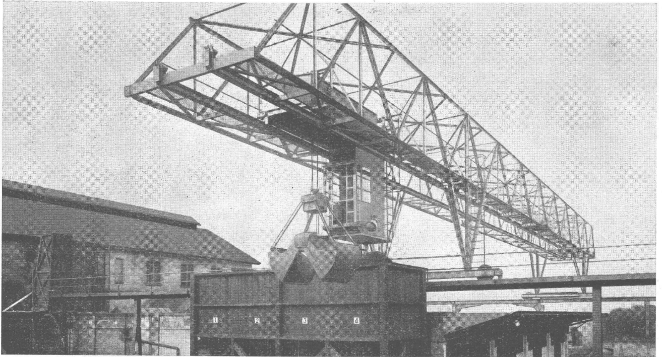
Verladebrücke in Schweisskonstruktion 2,5 t Tragkraft, 46 m Länge
