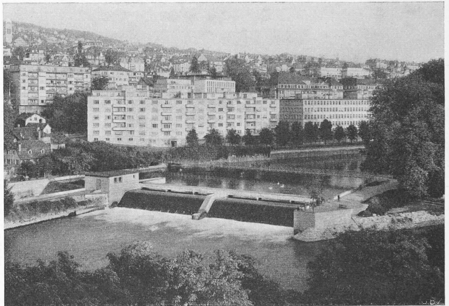
Bild 5. Hydraulische Dachwehranlage beim Platzspitz
