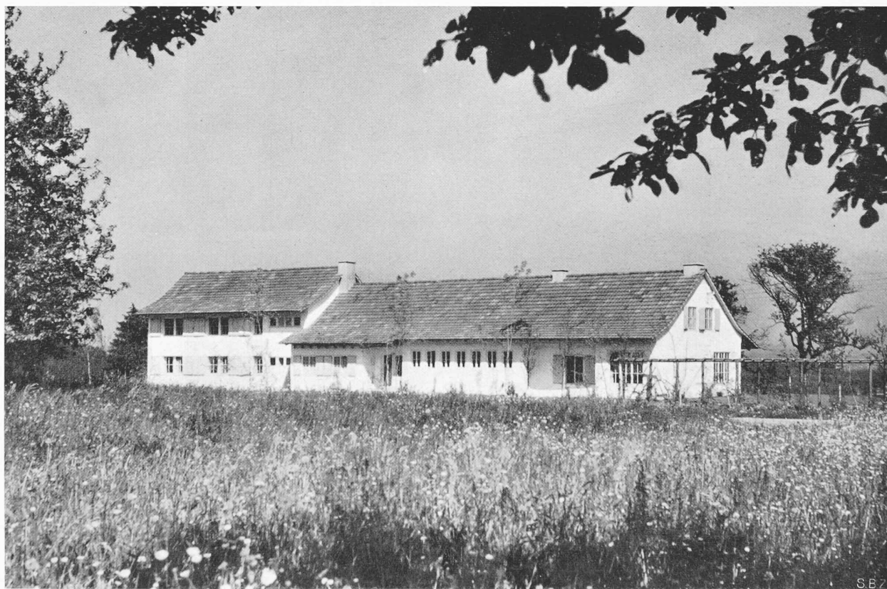
Das Haus für Erwachsene aus Südwesten, Eingangsseite, links Schlafteil, rechts Wohnteil
