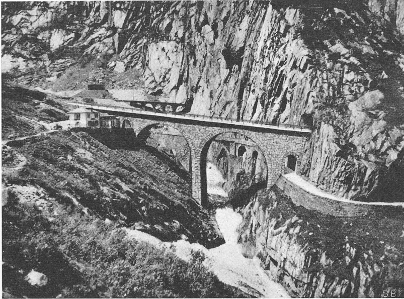
Bild 9. Viadukt mit zwei Oeffnungen (vgl. Bild 6, S. 64)
