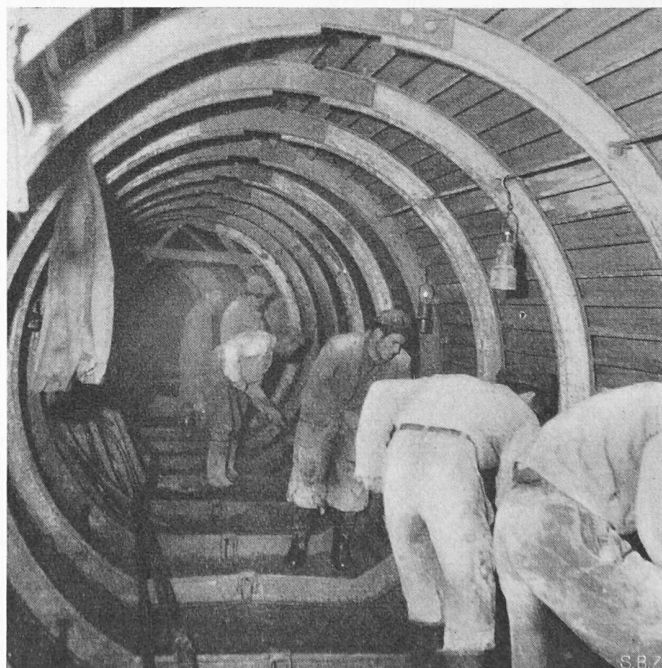
Bild 8. Leichtmetallschalungen für die Stollenbetonierung
