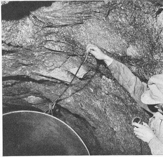
Bild 10. Schweissnahtprüfung im Druckschacht. Die Strahlenquelle aus Ir 192 wird am Ende der Stahlrute zwischen Rohr und Fels eingeführt
