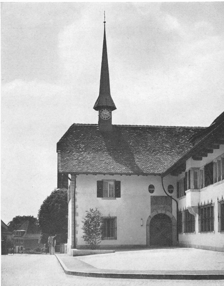
Vorbau mit Haupteingang
