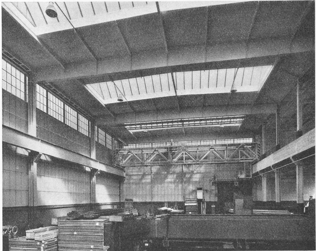
Bild 1. Blick in die Bearbeitungshalle; rechts Eisenbetonbrüstungsträger als Kranbahnträger Photos Beringer & Pampaluchi, Zürich
