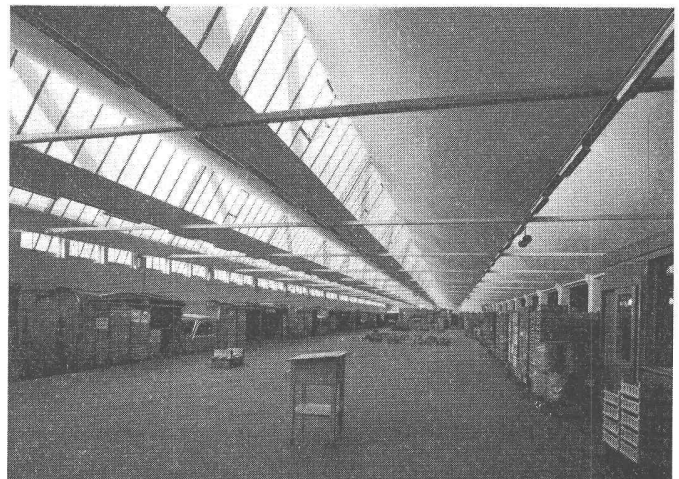
Shedbau für Lagerhalle
