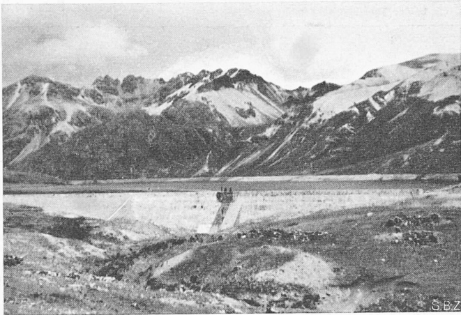
Bild 2. Staumauer des Speichers Sacsá auf 4400 m Meereshöhe; Nutzinhalt 16 Mio m 3
