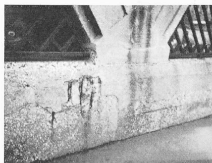
Bilder 43 bis 45. Schäden am Eisenbeton des Pont Lafayette über die Gare de l'Est in Paris
