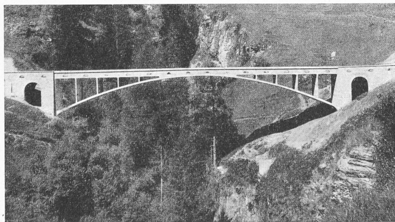
Bild 60. Strassenbrücke über das Val Tschiel bei Donath, Kt. Graubünden, 1925. Versteifter Stabbogen von 43,2 m Stützweite. Elegante technische Lösung mit selbstverständlicher organischer Gliederung des Tragwerkes von kühner, schönheitlich vollendeter Wirkung.
