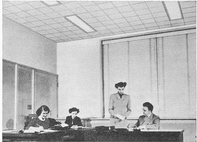
Bild 7. Bureauraum im ALCOA-Wolkenkratzer mit Frenger-Decke für Heizung im Winter und Kühlung im Sommer und mit versenkten Beleuchtungskörpern.
