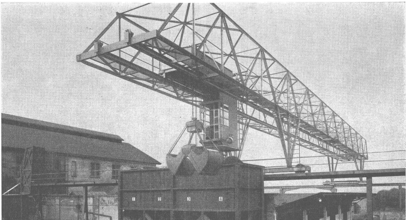
Verladebrücke in Schweisskonstruktion 2,5 t Tragkraft, 46 m Länge
