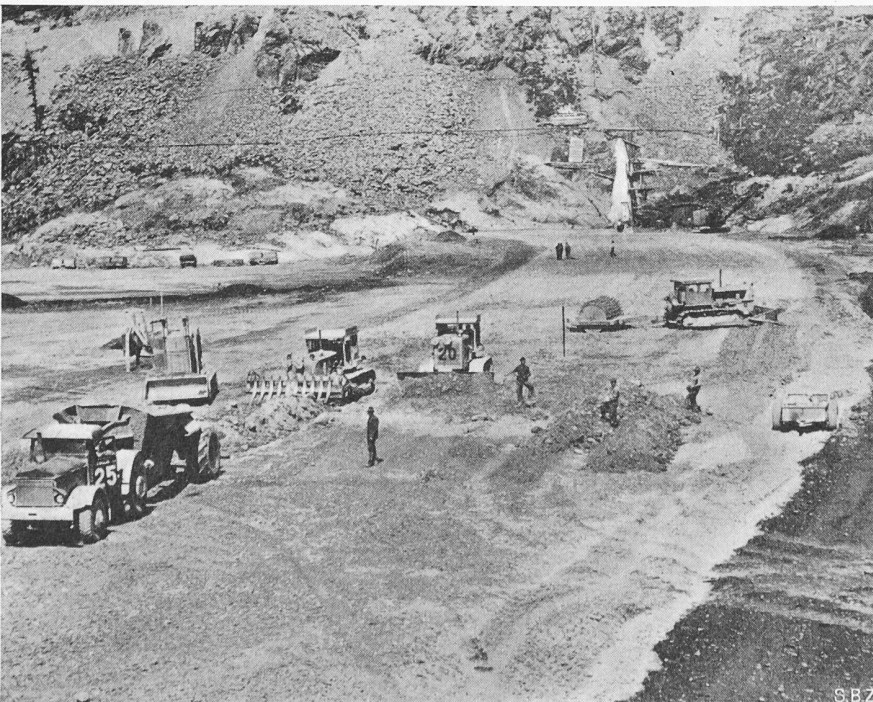
Bild 11. Aufbringen und Verdichten des Materials der Zone 1. Rechts Ausscheiden der grossen Steine, die für Zone (4) verwendet werden.
