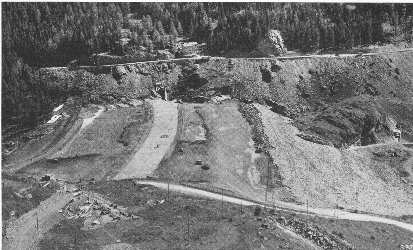
Bild 3. Uebersicht über die Dammbaustelle, im Hintergrund die neue Julierstrasse.
