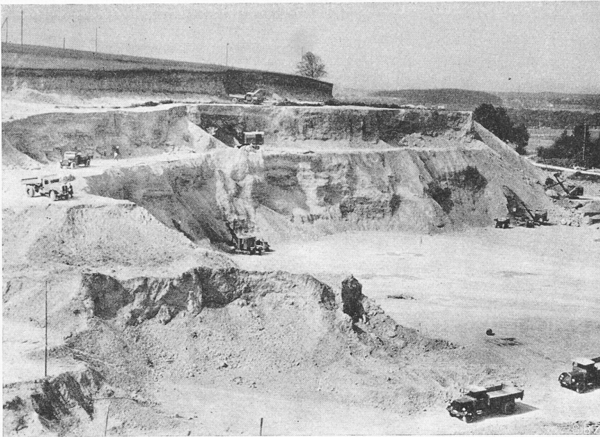
Bild 21. Kiesgewinnung am Holberg, mit terrassenförmigem Abbau (Photo Brügger, ETH)
