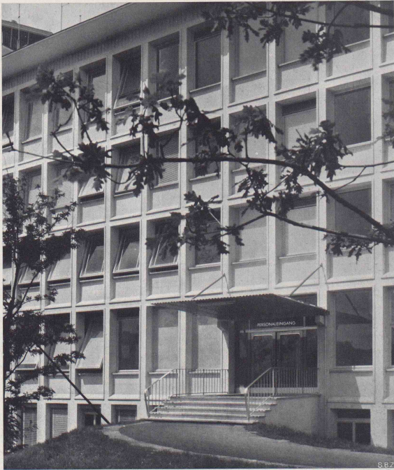
Bild 68. Fassadendetail des Bürotraktes, Seite Vorfahrt
