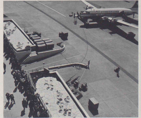
Bild 71. Blick auf den Flugsteig vom Kontrollturm aus, mit Gepäckkrane
