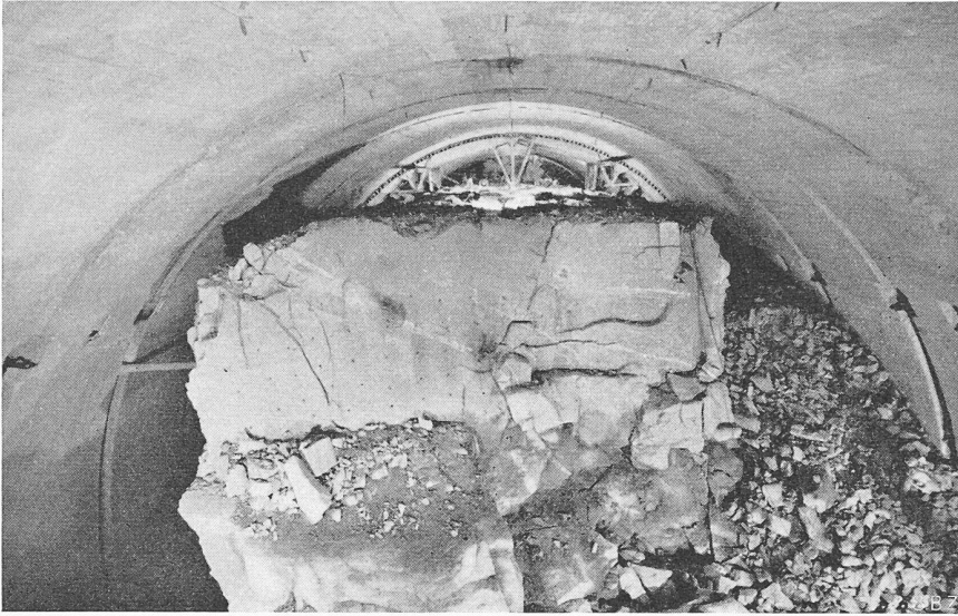
Bild 18. Kavernenbau für die Zentrale Caveragno
