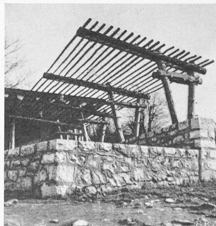
Detail der Restaurationsterrasse
