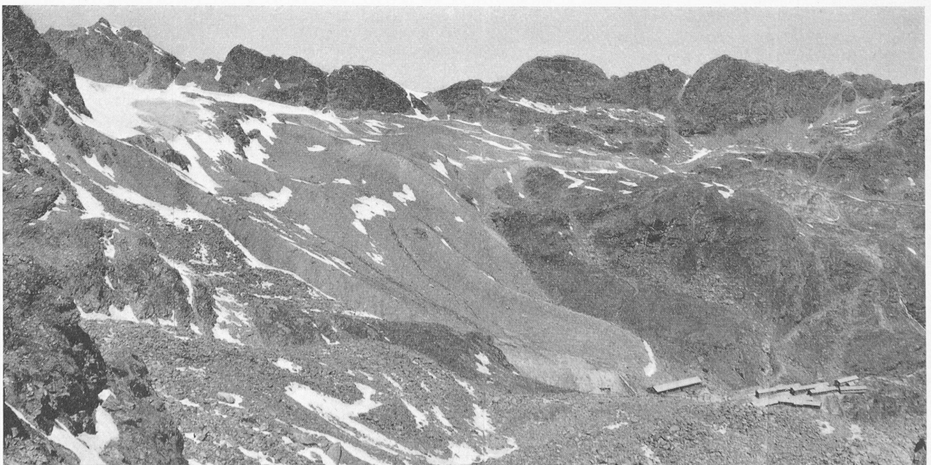
Bild 11. Stirmoräne bei Parfleuri im Abbau, als Betonzuschlagstoff für die Gewichtstamauer Grande Dixence. Photo Grande Dixence S. A.
