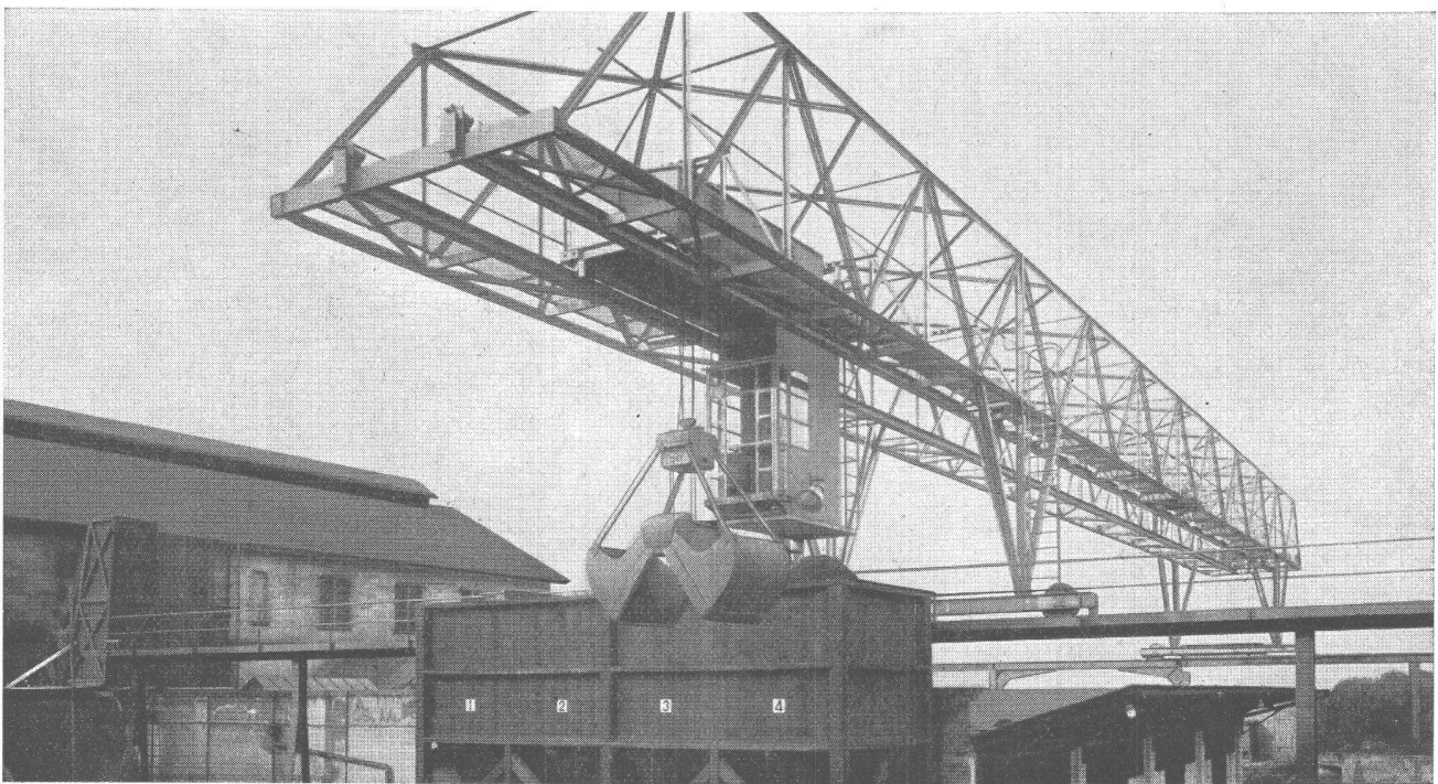
Verladebrücke in Schweisskonstruktion 2,5 t Tragkraft, 46 m Länge
