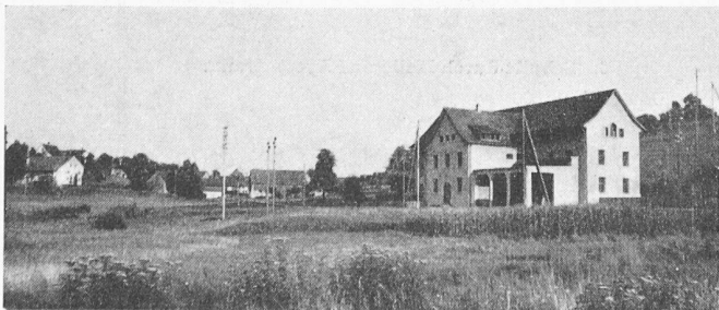
Bild 1. Das Unterwerk Aathal bei Uster (Baujahr 1919), im Hintergrund die Häuser von Sack-Heusberg. Zu grosser Baukörper
