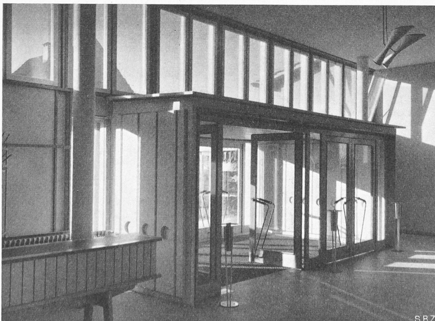
Bild 2. Haupteingangstüren von der Halle aus gesehen. Die Decke ruht auf den Stützen; die Fassadenfront (in Holz) ist davorgestellt
