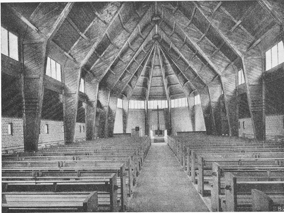
Bild 7. Notkirche, typisiert und vorfabriziert. Arch. O. BARTNING
