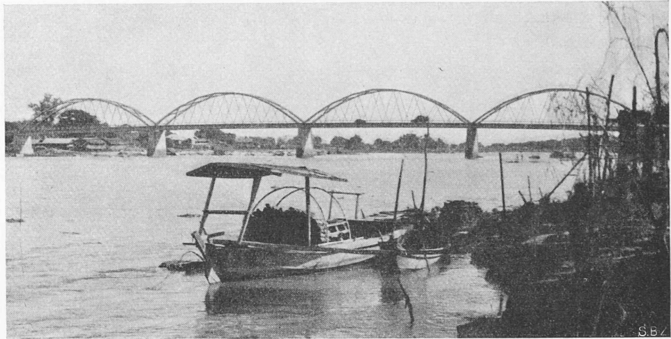
Bild 8. Die vier Flussöffnungen: versteifte Stabbogen mit dreieckförmig angeordneten Aufhängungen
