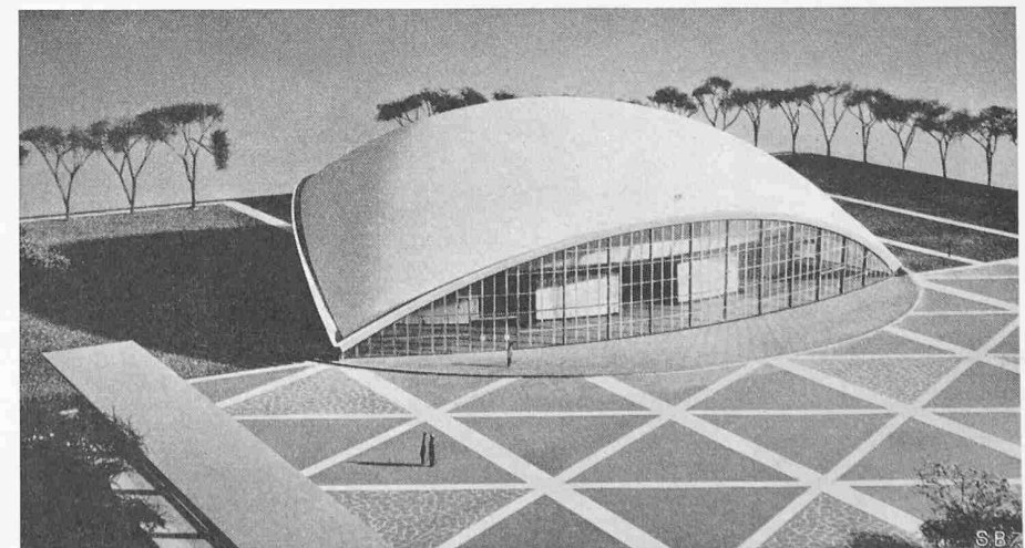
Bild 7. MIT-Auditorium in Cambridge, Mass. (Baubeginn 1953)
