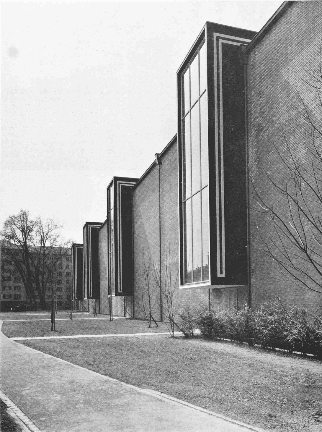
Treppenhäuser an der Mattenstrasse
