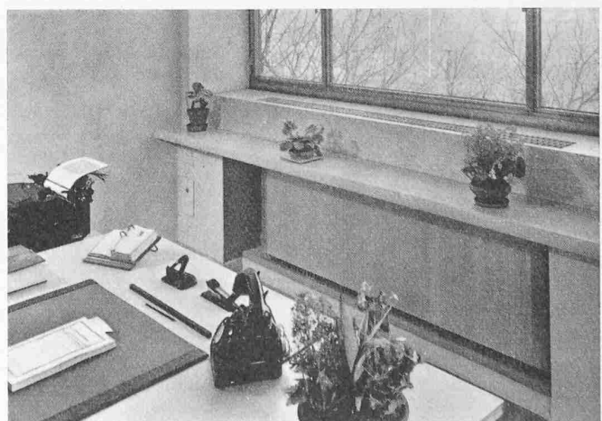
Bild 7. Einbau eines Jettair-Apparates in einem Bürauraum
