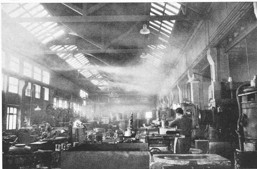
Bild 13. Die durch Rauchentwicklung sichtbar gemachte Raumluft steigt entsprechend der künstlichen Entlüftung mit etwa 1 m/min. gleichmässig nach oben
