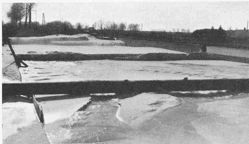
Bild 4. Transport durch Druckwasser in Beton-Silos
