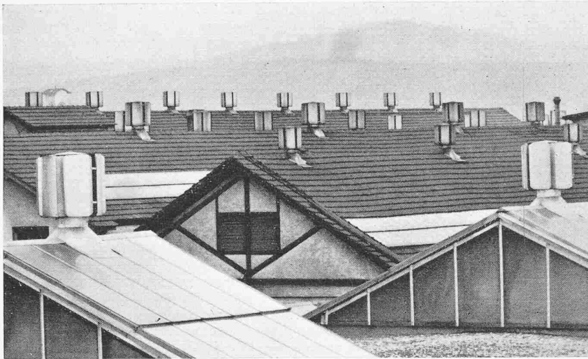
Bild 15. Falsche und richtige Ausbildung der Exhaustoren
