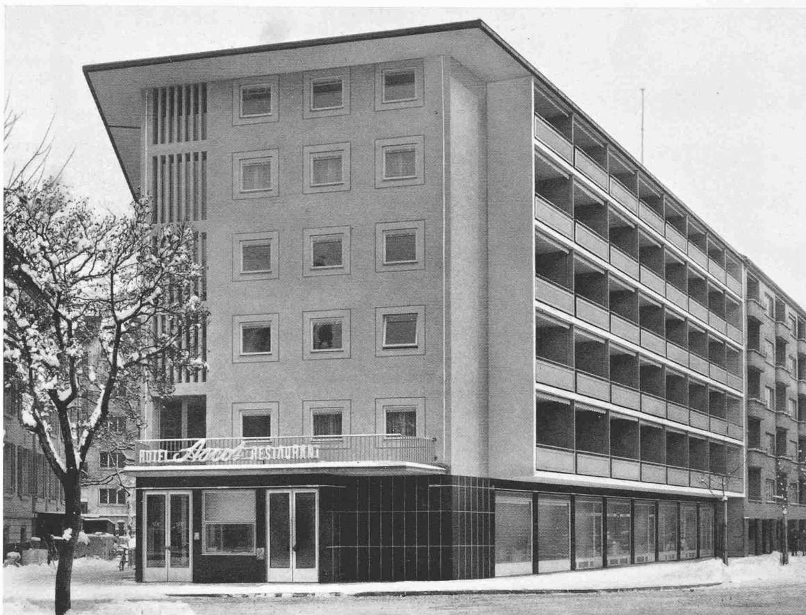
Ansicht von der Lavaterstrasse
