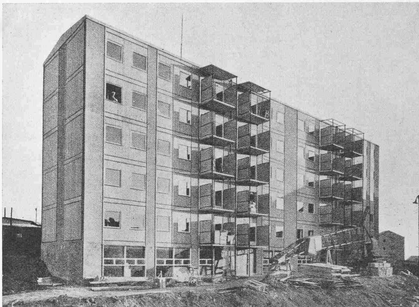
Bild 3. Fassade von Nordwesten
