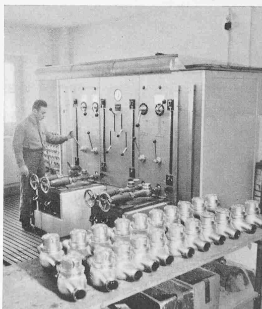
Fig. 11. Essais de compteurs à la station d'étalonnage
