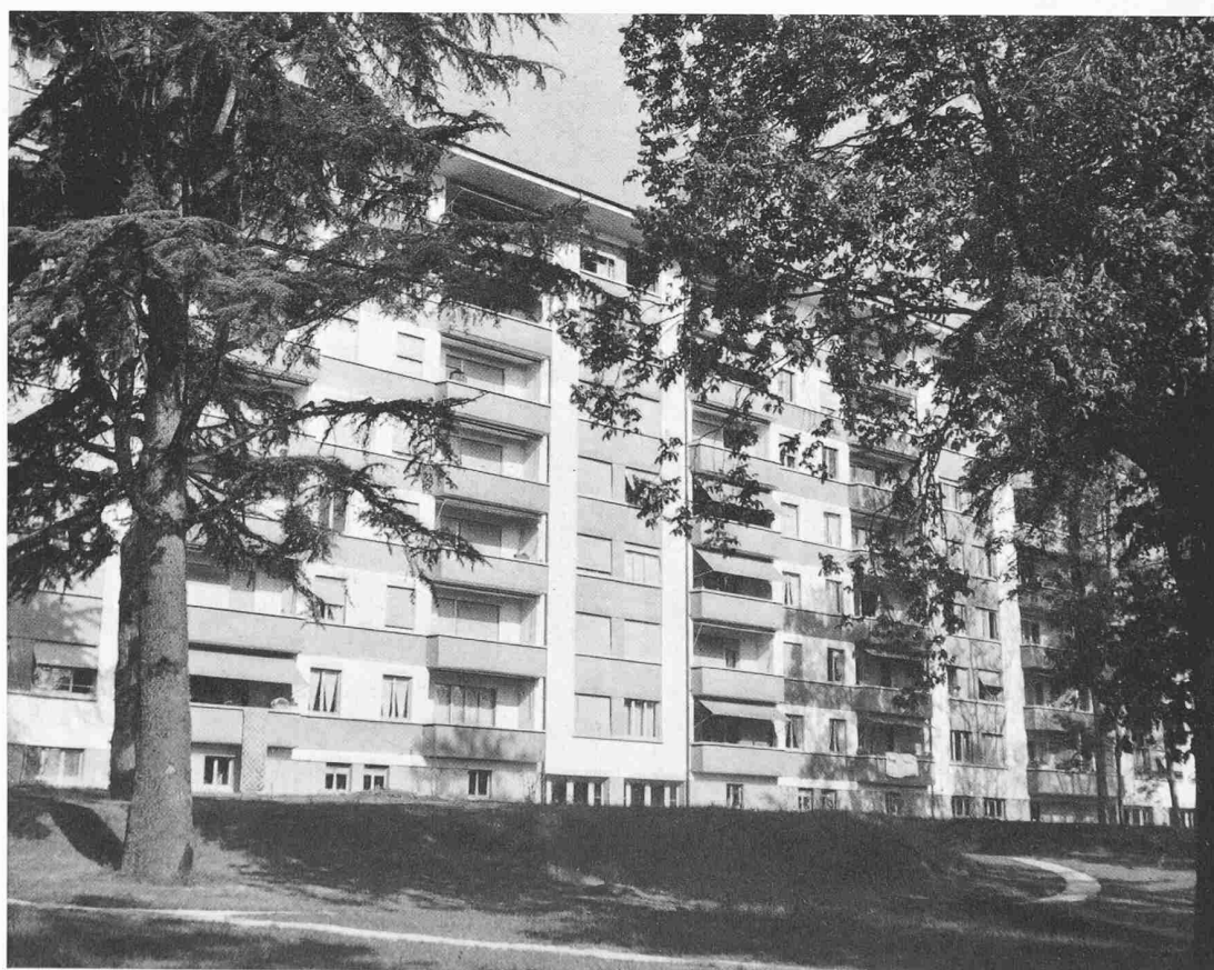
Wohnblock «Montbrillant Parc» aus Osten
