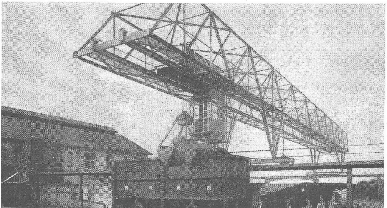
Verladebrücke in Schweisskonstruktion 2,5 t Tragkraft, 46 m Länge
