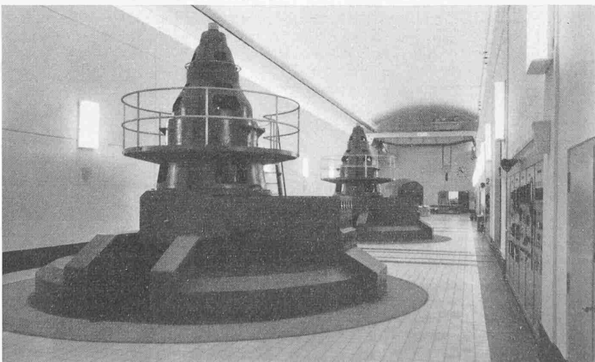
Bild 5. Indirekte Raumbelichtung aus Hohlkehlen über der Kranbahn, verbunden mit freistrahkenden Fluoreszenz-Leuchtern an den Wänden zur Verbesserung der Vertikal-Beleuchtung im Maschinensaal eines Kavernenkraftwerkes
