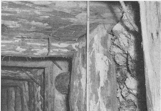
Fig. 3. On peut remarquer à droite l'écrasement du chapeau sur la pointelle. La roche molle flue autour de la pointelle de droite
