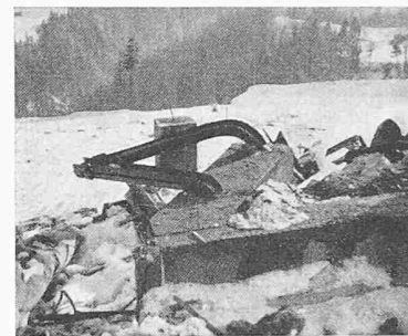
Bild 8a. Durch Lawine abgeogener Eisenständer
