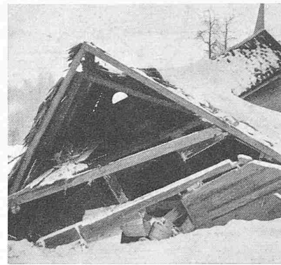
Bild 4. Mesmerhaus Blons. Das in Blockbauweise erstellte Haus wurde als Ganzes vom Fundament abgehoben, an eine seitliche Böschung transportiert, wo infolge der Schräglage der Dachstock vom übrigen Haus abglitt. Rechts die der Lawine zugekehrte Gebäudewand
