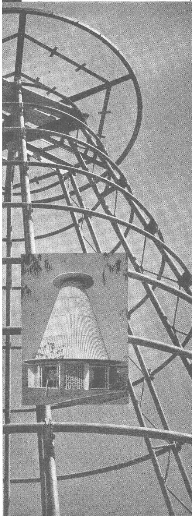
Teepavillon des Strandbades Tiefenbrunnen, Stahlskelett und fertiges Bauwerk
